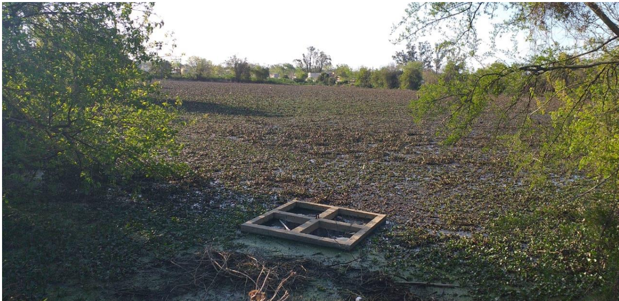
Figura 3. Vista hacia el norte de la salida de laguna facultativa existente.
